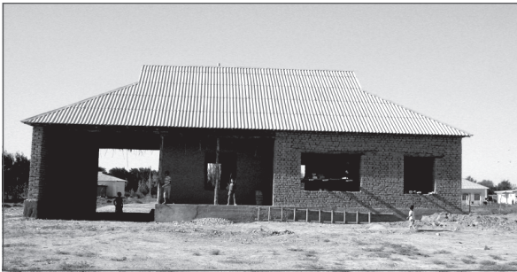
Foto:5- Şaga (Türkistan), yeni bina edilmiş bir evde malzeme ve darvaza (kapı) görünüşü, b. deniz, 2004.
